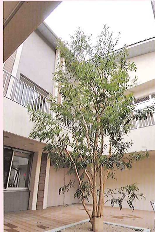
1階ユニット門のサンルーム
